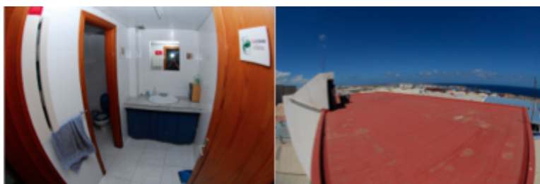
Cuarto de baño y azotea.
